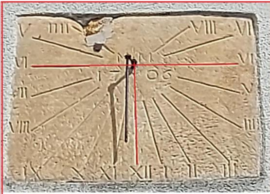
Le tracé du cadran est strictement méridional, avec VI et VI sur la même horizontale passant par le pied du style polaire et la verticale de midi bien perpendiculaire à cette horizontale VI - VI. Les lignes au-dessus de cet horizon sont inutiles : V et IIII à gauche; VIII et VI (mutilé) à droite.
